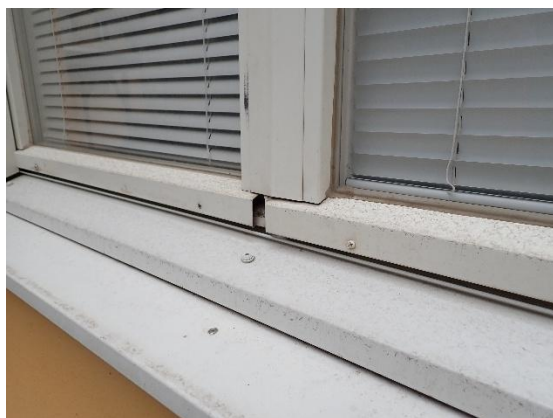
Fönster klädda med plåt
