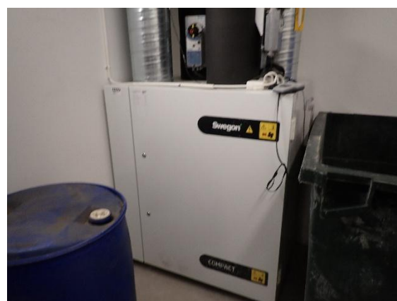
Ventilationsaggregat för lokalen
