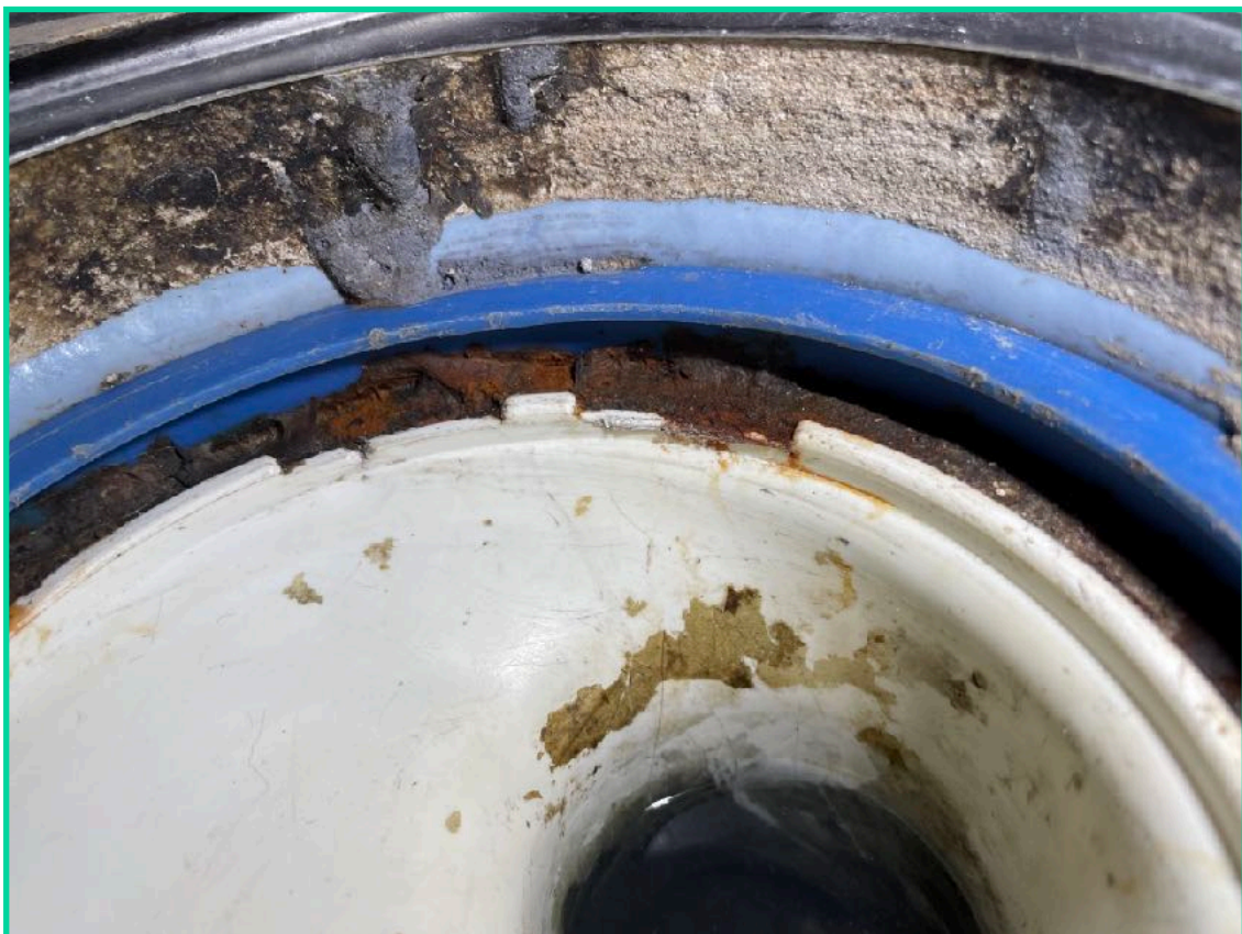
Äldre plastmatta, tidigare ytskikt, på vilken golvplattor monterats 2014.
