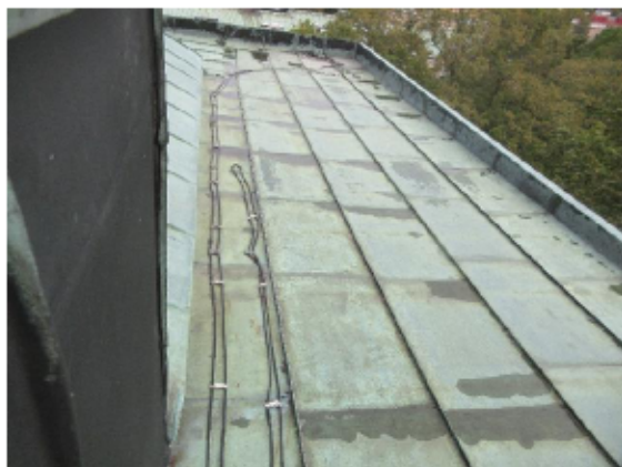
Låglutande delen av yttertaket
