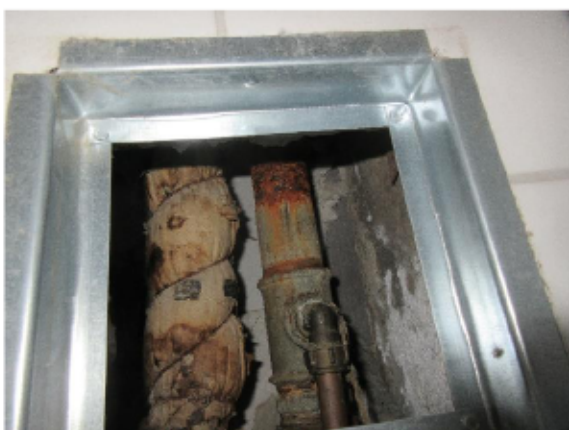
Galvaniserade kallvattenrör på stigarna
