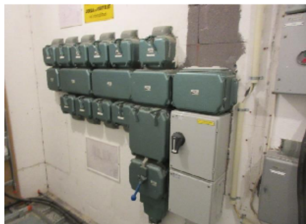
Varierande ålder på elektriska installationer
